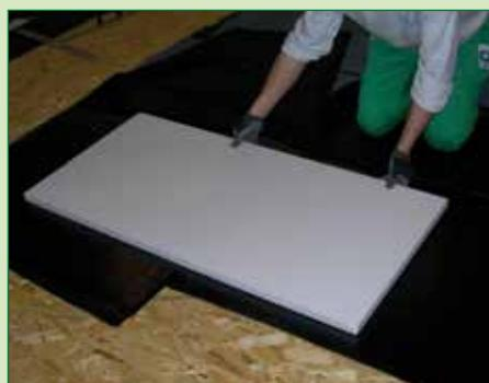
SELFTENE BV HE MONOADESIVO ALU POLIESTERE è la versione monoadesiva ad alta resistenza alla migrazione del vapore in bitume distillato polimero elastomerico per la posa della barriera al vapore su legno o lamiera grecata.
