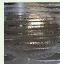
Insistendo con la sfiammatura, le strisce termoadesive assumeranno una consistenza semiliquida e lucida: la superficie sarà pronta a ricevere la posa dei pannelli o rotoli di isolante
