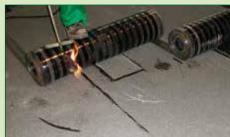
Nel caso, invece, di semplice rinnovamento di un manto bituminoso ancora ben aderente che non perde, ma con evidenti segnali di invecchiamento al quale si vuole prolungare la vita, è prevista la soluzione basata sulla posa in totale aderenza a fiamma della membrana MINERAL TECTENE RINOVA EP.
