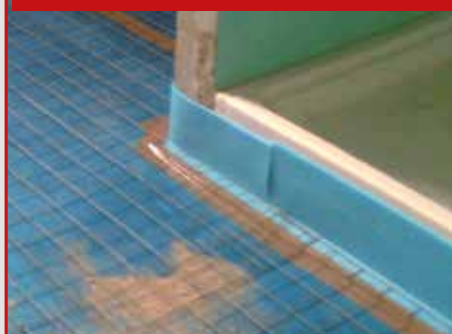
Distacco dei massetti del piatto doccia e della vasca con l'interposizione di FONOCCELL
