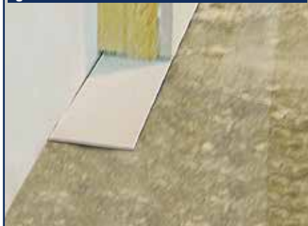
2. Posizionamento della fascia di guarnizione
