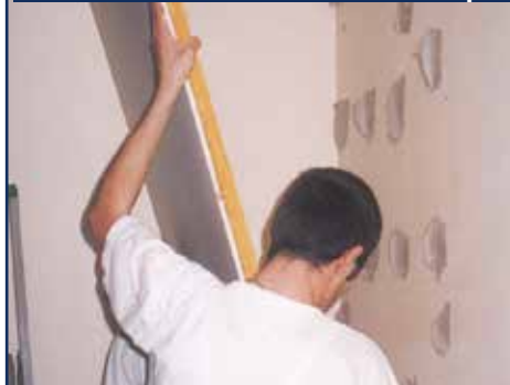
3. Posizionamento della lastra di SILENTGips
