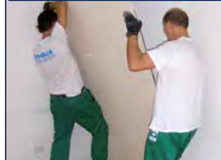
3. Posizionamento del pannello di TOPSILENTDuo
