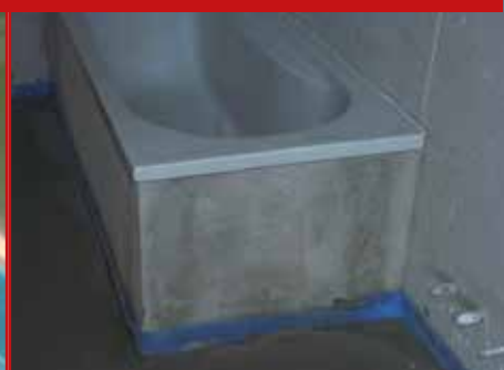
Distacco dei massetti del piatto doccia e della vasca con l'interposizione di FONOCCELL
