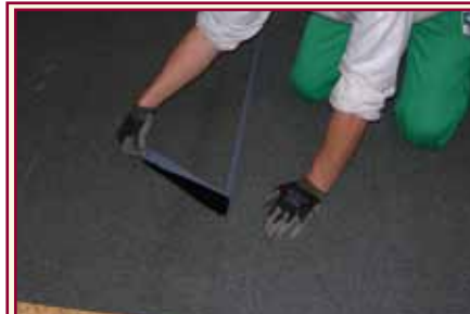
12. Alla fine si toglie la fascia bisiliconata che protegge la cimosa asportandola da sotto il sormonto e si pressa la membrana con il rullo metallico
