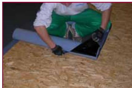
9. Si incide trasversalmente il film siliconato del primo mezzo rotolo
