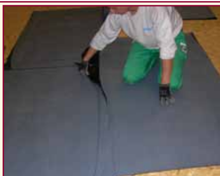
11. Si ripiega il film siliconato che era stato provvisoriamente spostato per fare il sormonto a protezione della superficie adesiva
