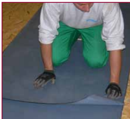
1. Si sovrappongono i teli per il sormonto di testa
