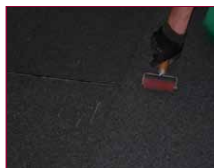
23. Si pressa poi accuratamente il sormonto
