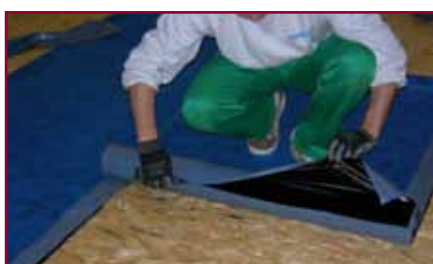
10. Si predispone il foglio adiacente sfalsando il sormonto di testa dei teli fatta in precedenza
