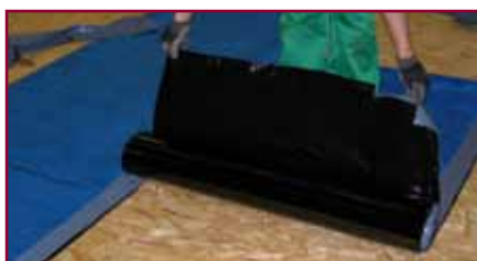
7. Dopo aver inciso il film siliconato si svolge il rotolo asportando contemporaneamente il film sottostante
