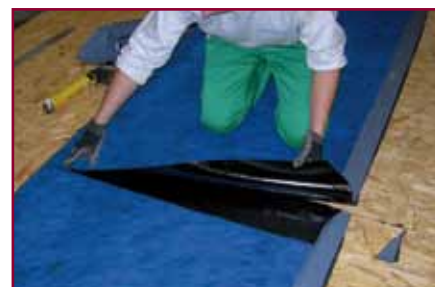
6. Si appoggia il lembo superiore sulla spalmatura
