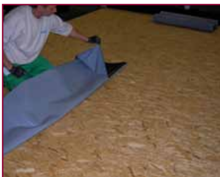
2. Si piega a metà il foglio lungo l'incisione del film siliconato
