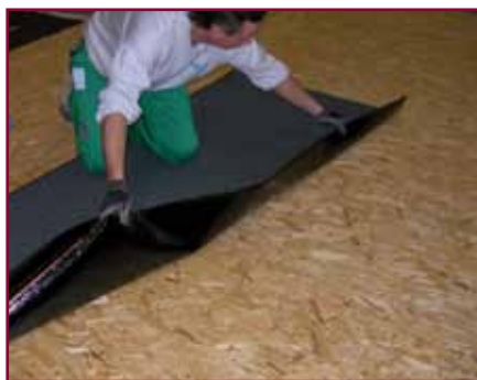
4. Si risvolta la membrana sul piano di posa
