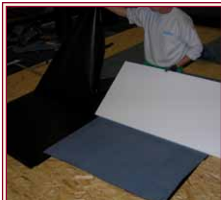
11. Si ripiega il film siliconato che era stato provvisoriamente spostato per fare il sormonto a protezione della superficie adesiva
