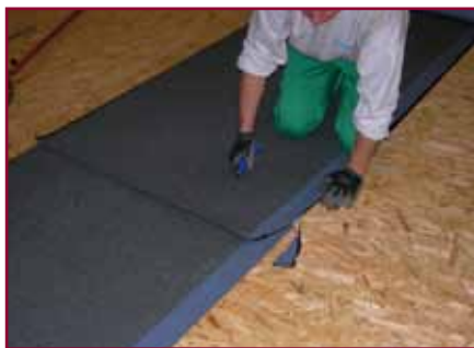
10. Si smussa l'angolo del lembo superiore del sormonto
