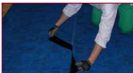
8. Infine si toglie la fascia bisiliconata che protegge la cimosa adesiva da sotto la sovrapposizione e si pressa accuratamente con rullo
