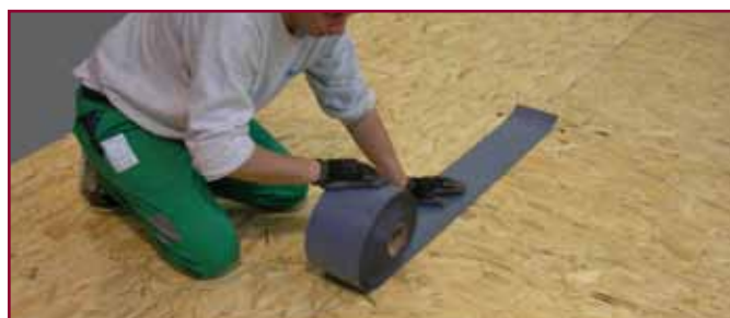
2. A cavallo delle linee si predispose una fascia di SELFTENE BV BIADESIVO larga 14 cm
