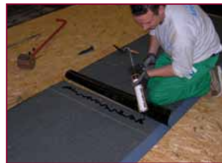
12. Dopo aver segnato l'area di sormonto si estrude la colla HEADCOLL
