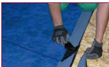
2. Si smussa l'angolo del lembo superiore del sormonto
