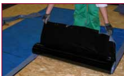
11. Dopo aver inciso il film siliconato si svolge il rotolo asportando contemporaneamente il film sottostante
