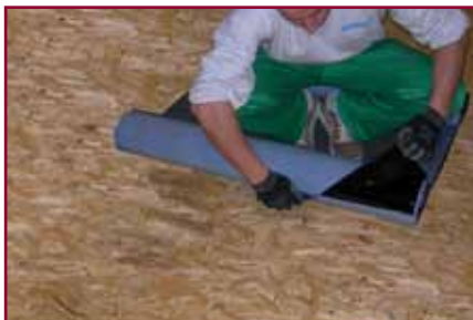
2. Si incide trasversalmente il film siliconato del primo mezzo rotolo
