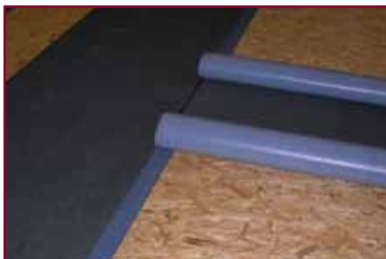
8. Il rotolo da posare accanto ai precedenti viene svolto, allineato sul sormonto e riavvolto in due mezzi rotoli
