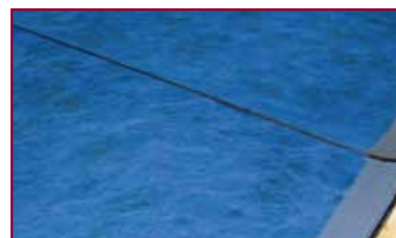
3. Si segna il limite del sormonto per la spalmatura della colla
