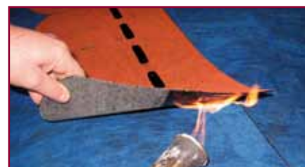
9. Successivamente si incollano a fiamma le tegole tipo canadesi COVERTILE sulla finitura Texflamina di TECTENE TEGOLA EP POLIESTERE
