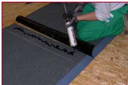
4. Dopo aver segnato l'area di sormonto si estrude la colla HEADCOLL
