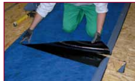
3. Si appoggia il lembo superiore sulla spalmatura
