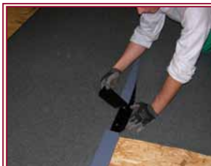
22. Infine si asporta la fascia bisiliconata che protegge la sovrapposizione laterale togliendola da sotto il sormonto
