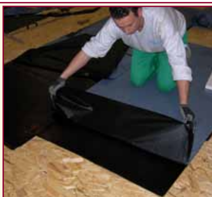
11. Si ripiega il film siliconato che era stato provvisoriamente spostato per fare il sormonto a protezione della superficie adesiva
