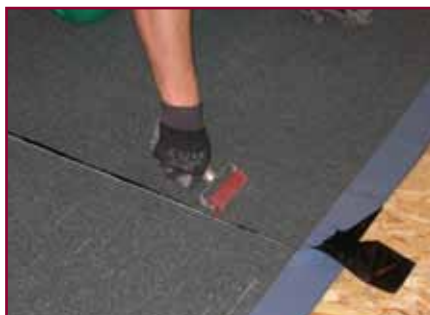
14. Si pressa il sormonto con un rullino a partire dalla linea inferiore del sormonto
