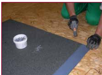
7. Prima di procedere alla giunzione di testa con il foglio successivo si chioda la membrana sotto la zona di sormonto
