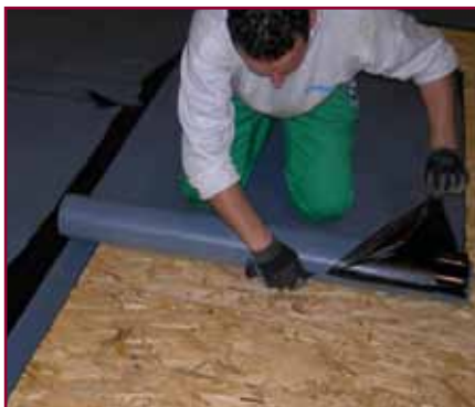
7. Si predispose il foglio adiacente sovrapponendolo sulla cimosa bisiliconata dei teli già incollati
