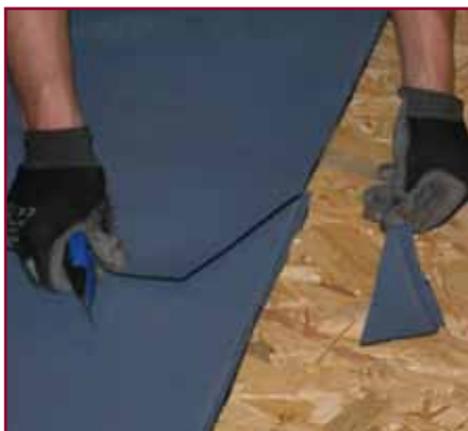
2. Si smussa l'angolo del lembo superiore del sormonto
