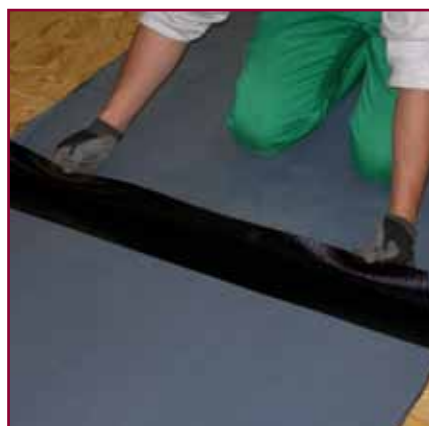
5. Si stende il lembo superiore del sormonto
