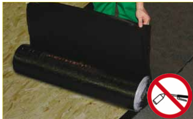
Posa a freddo per semplice pressione delle membrane autoadesive SELFTENE EP
