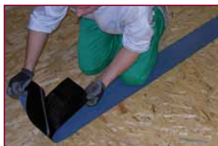
3. Si toglie il film siliconato dalla faccia inferiore
