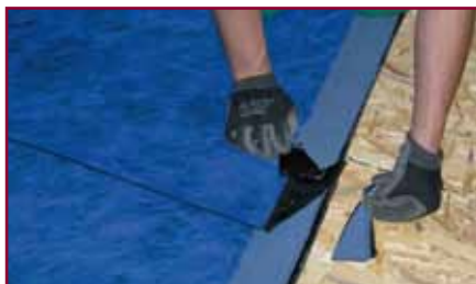
1. Si smussa l'angolo del lembo superiore del sormonto
