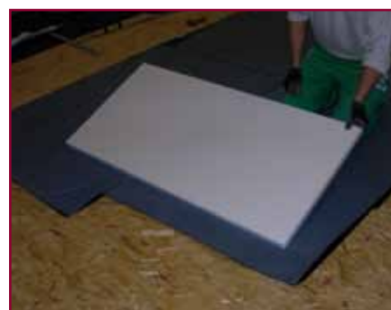
12. Si procede nella posa del pannello isolante
