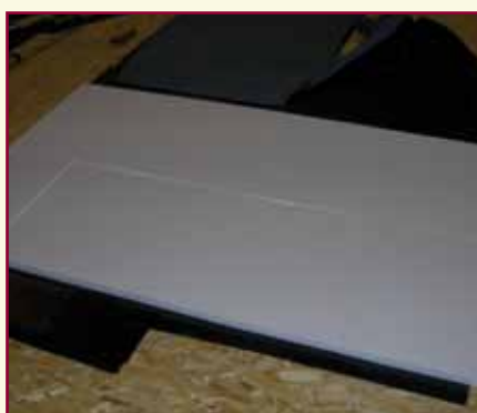
13. Si asporta il film siliconato che protegge la faccia superiore man mano che si incollano i pannelli isolanti per evitare la polvere e l'appiccatura degli operatori. Dopo aver appoggiato i pannelli sulla superficie adesiva si pressano accuratamente con i piedi per rafforzare l'adesione.
