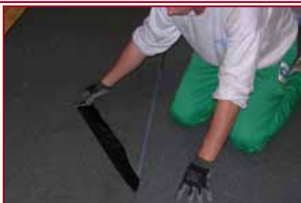
12. Alla fine si toglie la fascia bisiliconata che protegge la cimosa asportandola da sotto il sormonto e si pressa la membrana con il rullo metallico
