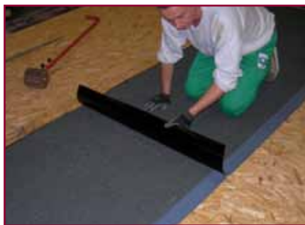
11. Si segna la faccia superiore lungo la linea di sormonto
