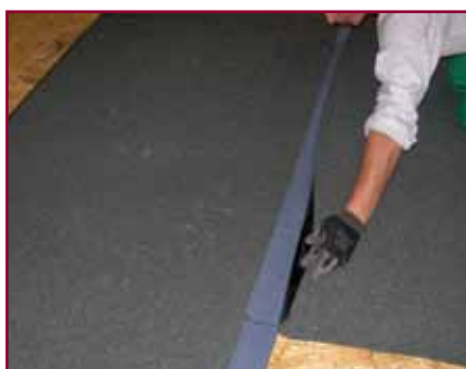
20. Si risvolta la membrana sui fogli già incollati
