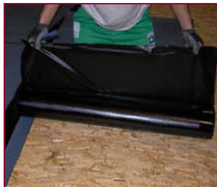
8. Si asporta il film siliconato dalla faccia inferiore
