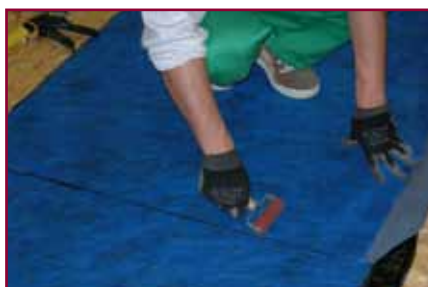
8. Si pressa poi accuratamente la zona di sovrapposizione
