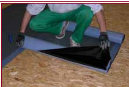
8. Il rotolo da posare accanto ai precedenti viene svolto, allineato sul sormonto e riavvolto in due mezzi rotoli
