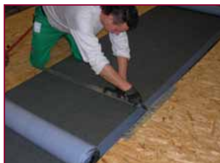
9. Si taglia il secondo foglio per il sormonto di testa
