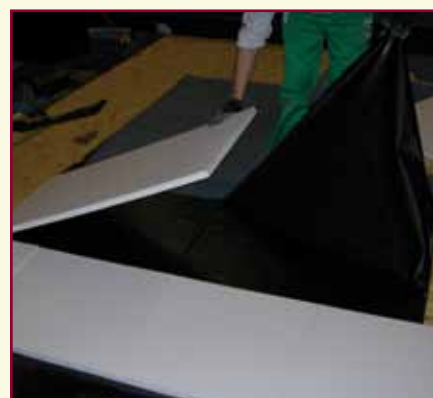
13. Si asporta il film siliconato che protegge la faccia superiore man mano che si incollano i pannelli isolanti per evitare la polvere e l'appiccatura degli operatori. Dopo aver appoggiato i pannelli sulla superficie adesiva si pressano accuratamente con i piedi per rafforzare l'adesione.
