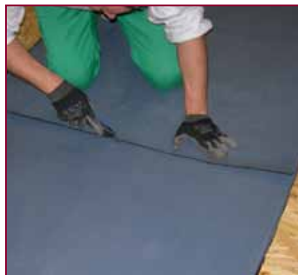
3. Si incide il film siliconato della faccia superiore lungo la linea di sormonto
