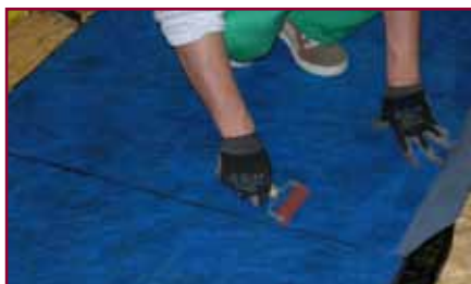
4. Si pressa poi accuratamente la zona di sovrapposizione
