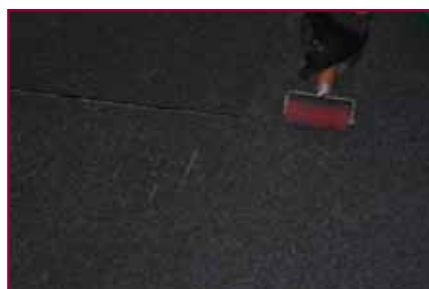
13. Si pressa poi accuratamente il sormonto
