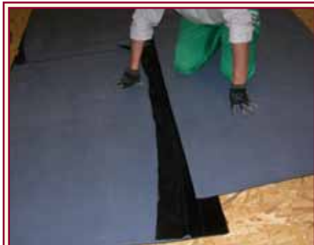
11. Si ripiega il film siliconato che era stato provvisoriamente spostato per fare il sormonto a protezione della superficie adesiva
