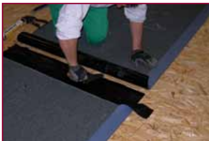
5. Si spalma uniformemente la colla con una cazzuola e si sigilla la linea di smusso con un cordolo estruso della stessa colla
