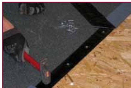
6. Asportando provvisoriamente la fascia bisiliconata si chioda la cimosa dei teli incollati in precedenza
