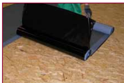
11. Si incolla il rotolo sul piano di posa usando il film siliconato intero per svolgerlo
