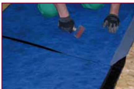
7. Si pressa con un rullino iniziando dalla linea inferiore del sormonto
