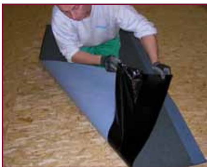
5. Si ripete l'operazione sull'altra metà della membrana
