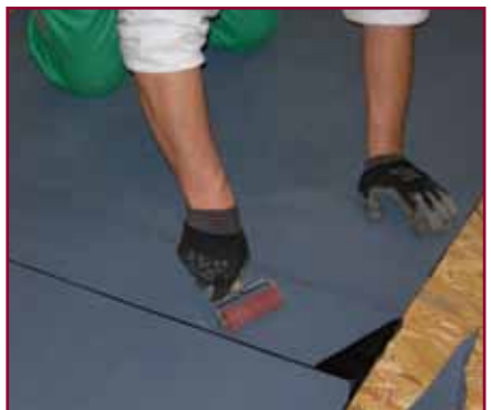
6. Si pressa l'area di sormonto con un rullino a partire dalla linea inferiore di sormonto
