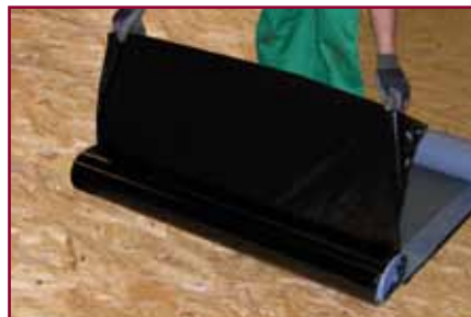
3. Si incolla il rotolo sul piano di posa usando il film siliconato intero per svolgerlo
