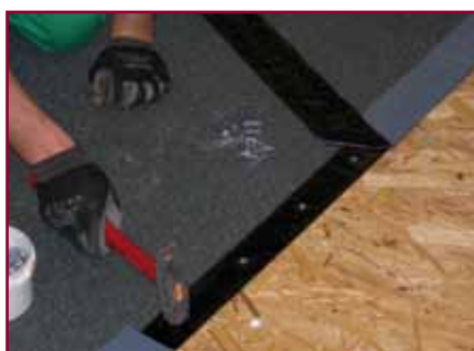
17. Asportando provvisoriamente la fascia bisiliconata si chioda la cimosa dei teli incollati in precedenza
