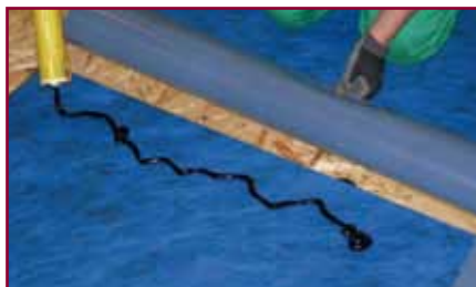
2. Si estrude la colla HEADCOLL nell'area di sormonto
