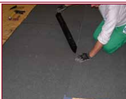
22. Infine si asporta la fascia bisiliconata che protegge la sovrapposizione laterale togliendola da sotto il sormonto
