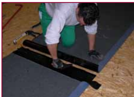
13. Si spalma uniformemente la colla con una cazzuola e si sigilla la linea di smusso con un cordolo estruso della stessa colla
