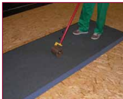
6. Si conferma l'adesione pressando la membrana con un rullo metallico
