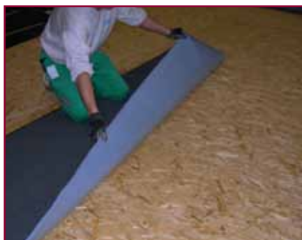
1. Si taglia il rotolo in pezzi di lunghezza inferiore a 4 m
