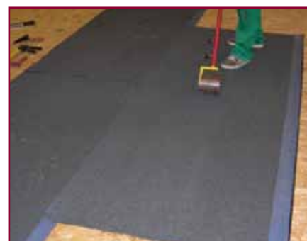
21. Si conferma l'adesione pressando la membrana con un rullo metallico
