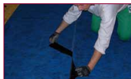
12. Infine si toglie la fascia bisiliconata che protegge la cimosa adesiva da sotto la sovrapposizione e si pressa accuratamente con rullo
